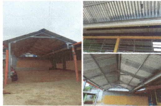
Foto 2: Cubierta de lámina para escenario e instalación de estructura de techo
