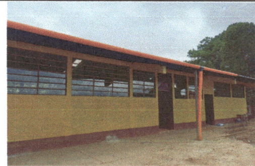
Foto 6: Canal pluvial para patio.
