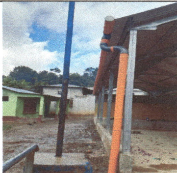
Foto 3: Colocación de canal pluvial para el área exterior del escenario.
