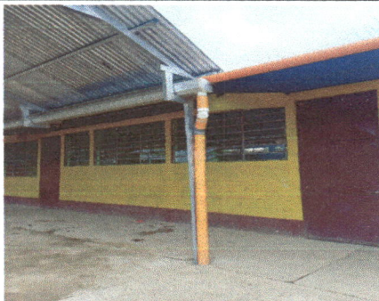
Foto 5: Ifabricación e instalación de canal pluvial para escenario.
