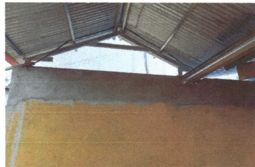
Foto 4: Seguimiento de pared de escenario y repello. Instalación de lamiluz para techo.
