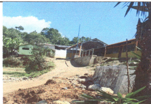
Foto 10: Muro de contención del área izquierda del centro educativo.
