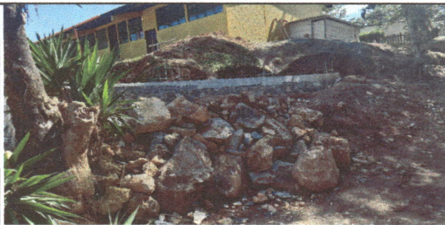
Foto 9: Avance de muro de contención del área derecha realizado con saldo de lo planificado.
